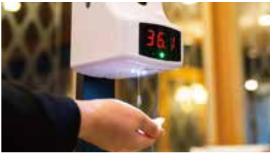
消毒液の設置 Setting sanitisers
